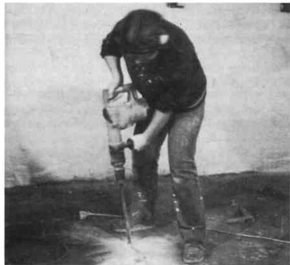
Brigitte beim Aufmeißeln des Kellerbodens
